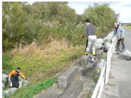
回収物の運び上げ
