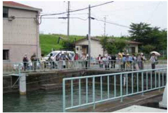
木屋揚水ポンプ場 淀川左岸地域の用水はここが基点
