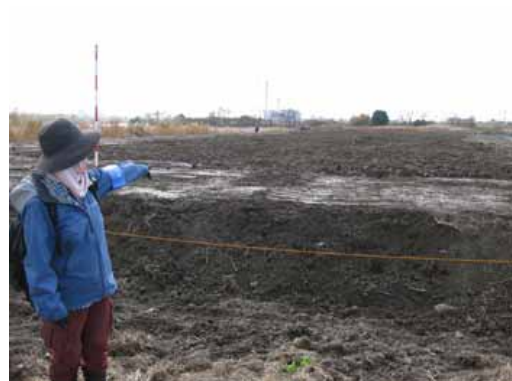
工事現場から掘り出した表土、後に埋め戻す
