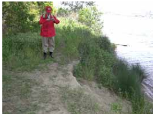
鳥飼大橋直下の危険箇所確認(5月2日)
