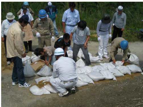
積み土のう工
