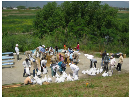
講師・スタッフ指導の下、土のう造り
