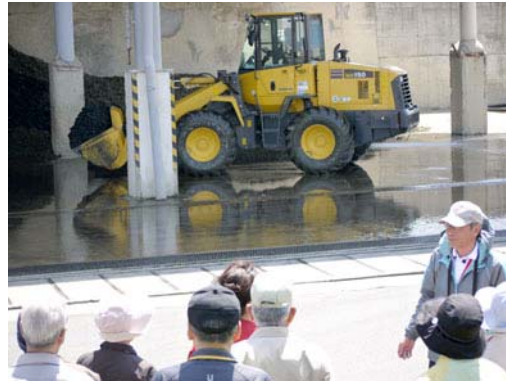
11:21 説明スタッフと柴島浄水場内の見学(汚泥処理)
