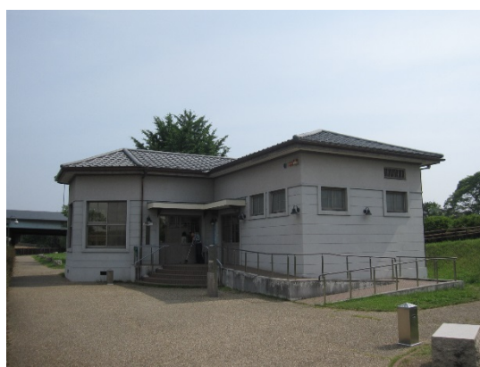
写真 1.1 三栖閘門資料館 全景
