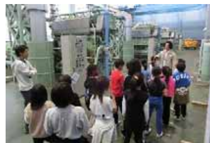
排水機場の見学
