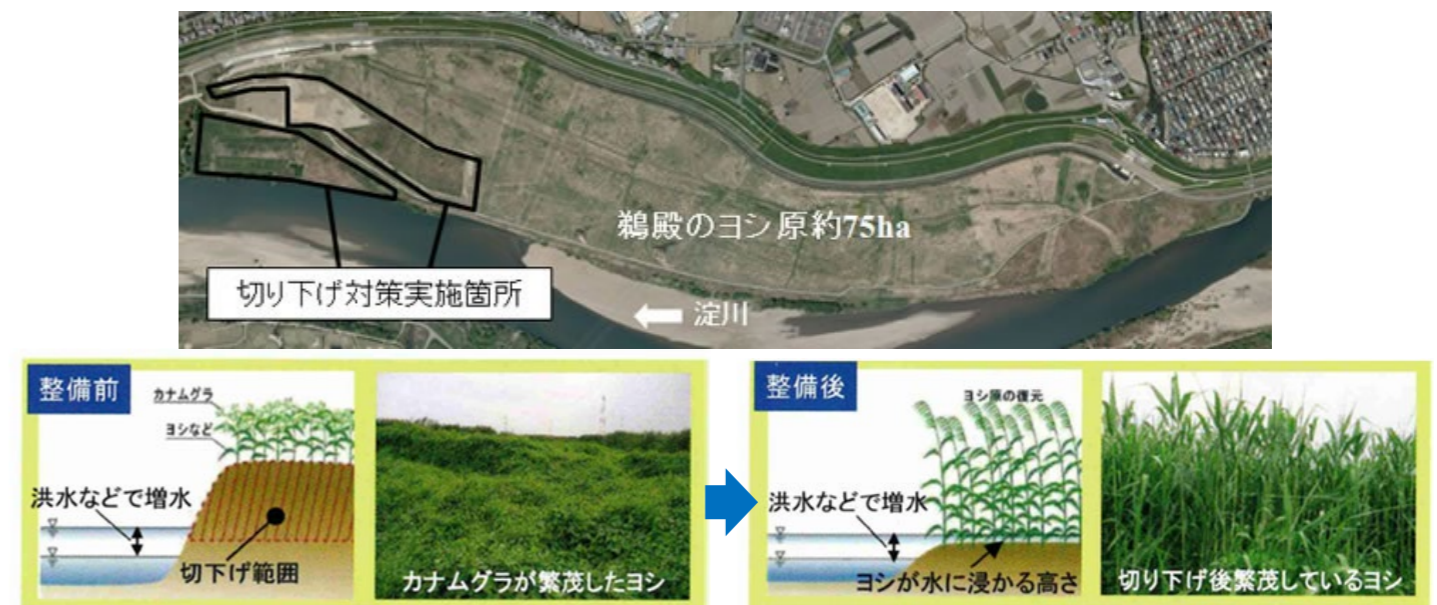
図 6.1 高水敷の切り下げによる鶴殿ヨシ原の保全イメージ (淀川河川事務所ホームページ / R6 年度事業概要より抜粋)
