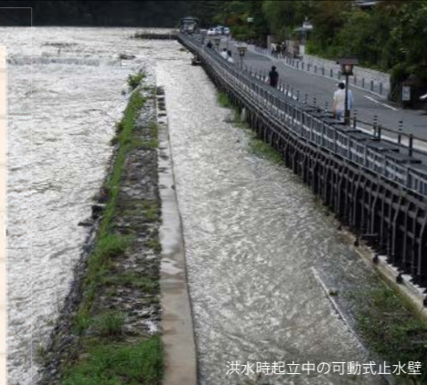
洪水時起立中の可動式止水壁
