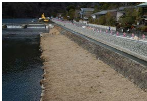
川側の石積み(施工中)
