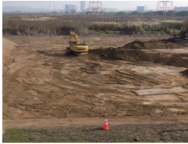
鶴殿ヨシ原の切り下げ工事
