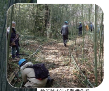
散策路の造成整備作業
