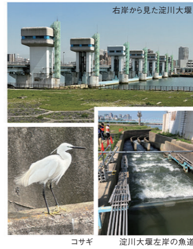
右岸から見た淀川大堰 コサギ 淀川大堰左岸の魚道
